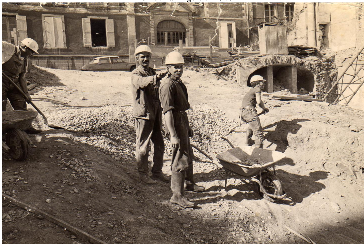
Photographie 4 : Mohamed et Mouloud, travaillant à la construction de l'Hôtel Le Grand Cercle, Bd Foch à Angers en 1973
